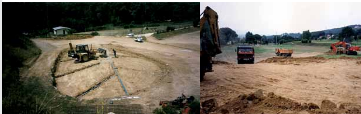
fotos: Imatges de la construcció dels camps de Vallromanes
